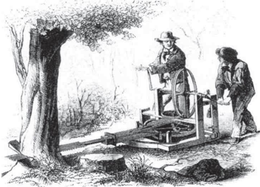
Ryc. 3. Piła do ścinki drzew napędzana siłą mięśni wynaleziona przez Hamiltona (Haim 2002)
